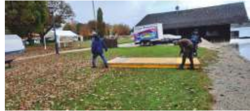
Die Konstruktion für den Hauptsteg, dann lange warten auf den LKW mit dem großen Zelt
